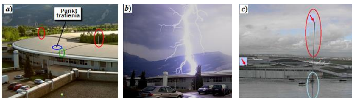
Rys 2.9. Ilustracja: a) ochrony budynku pierścieniowego 6-ma „zwodami ESE”, b) ich zawodności potwierdzonej wizualnie przez J. Howse w 2006 r. [1], c) ochrony hangaru.
